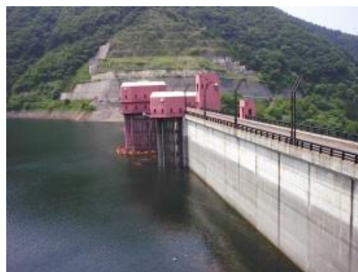
写真 1 浅瀬石川ダムと取水施設
