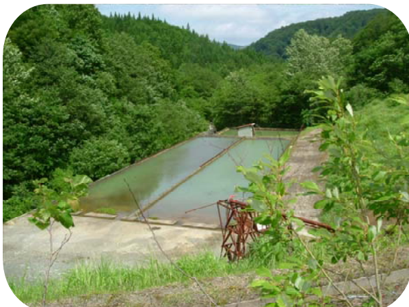
温川鉦山跡沈澱池
