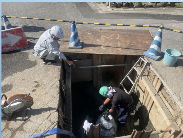
工事現場監理状況写真
