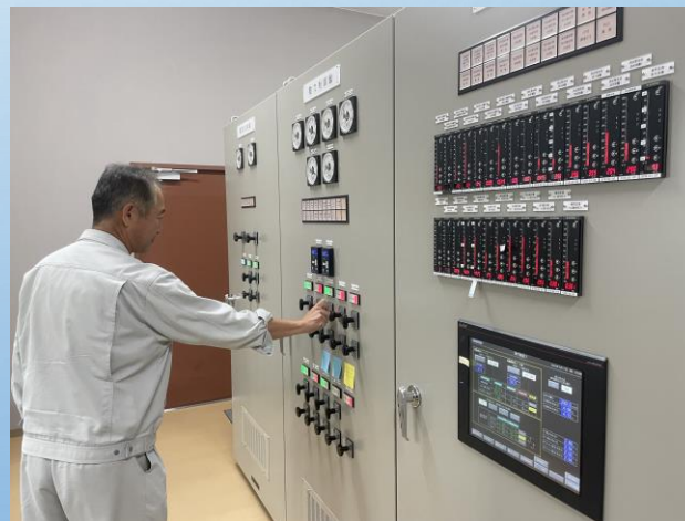
西北配水場管理状況写真
