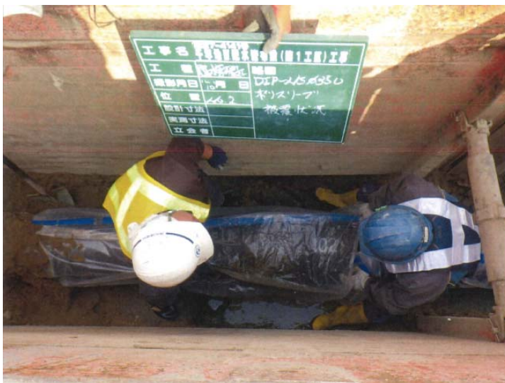
図表 4-11 配水管布設工事の様子
