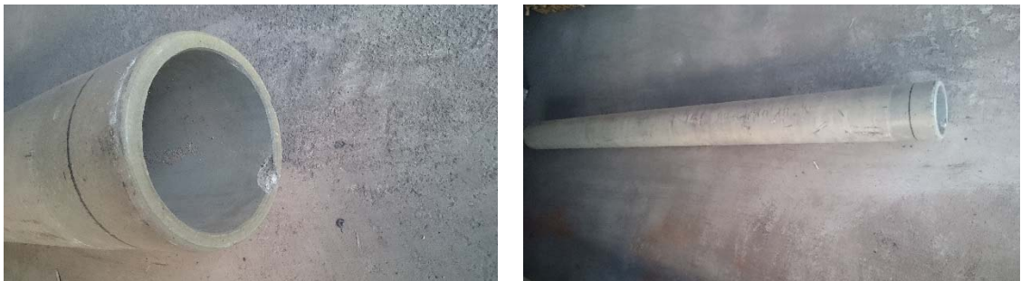
図表 3-18 石綿セメント管 (耐震性の低い水道管)
